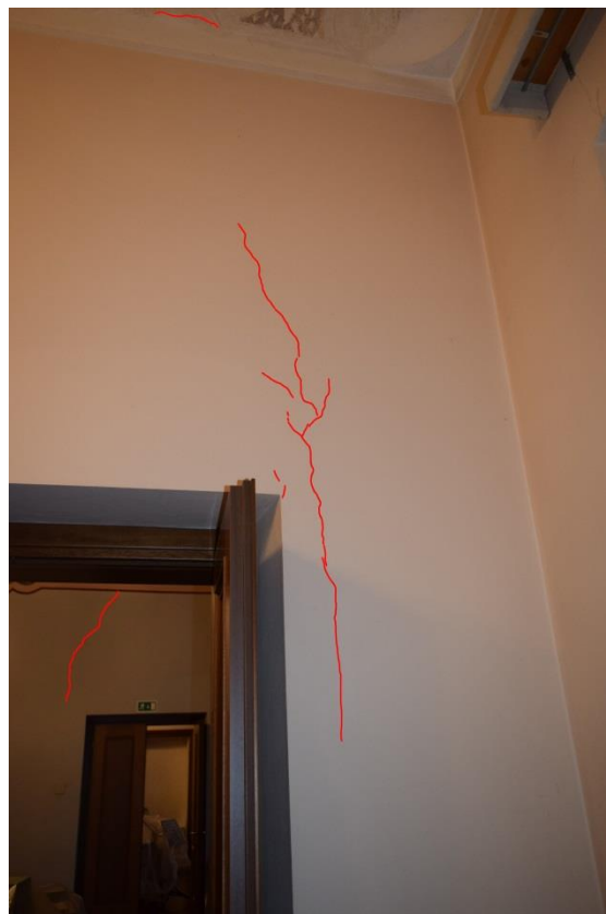
Sliki 3.31 in 3.32: Manjši salon v 1. nadstropju - razpoke v nosilnem zidu med tem prostorom in Dantejevo sejno sobo.
