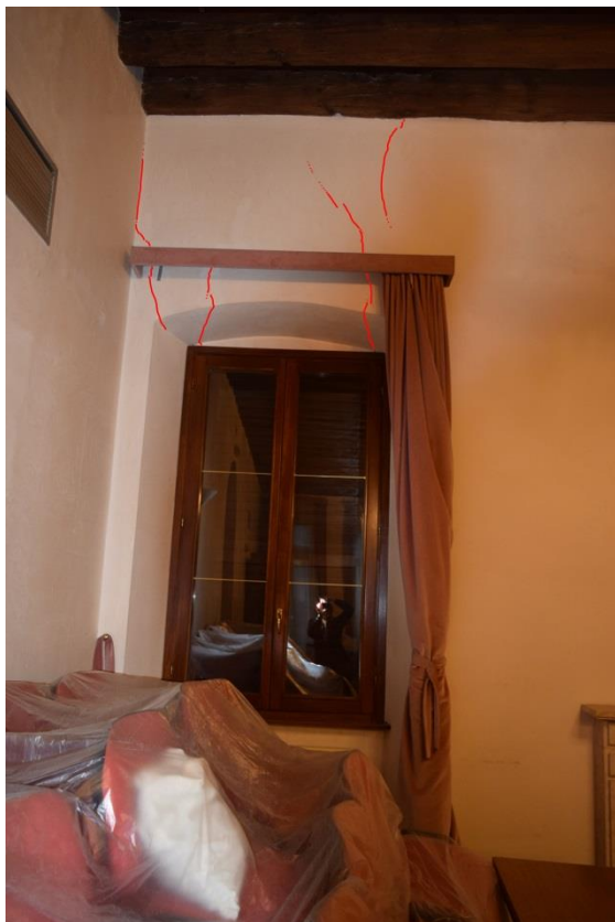
Sliki 3.22 in 3.23: Razpoke na krajnih robovih nadokenskih slopov v južnem zidu.
