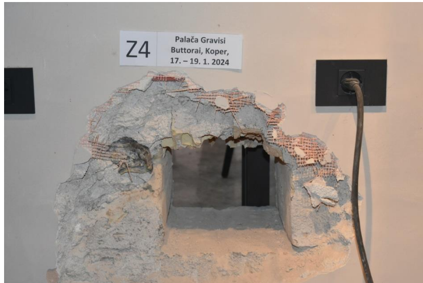
Slika 4.18: Pogled na mesto Z4 po odstranitvi opečnega zidaka.
