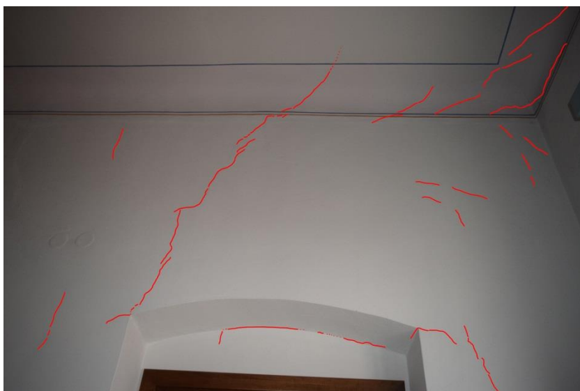
Slika 3.20: Pogled na zid in razpoke na drugi strani zidu s slike 3.19.
