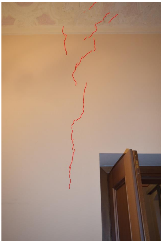
Sliki 3.31 in 3.32: Manjši salon v 1. nadstropju - razpoke v nosilnem zidu med tem prostorom in Dantejevo sejno sobo.
