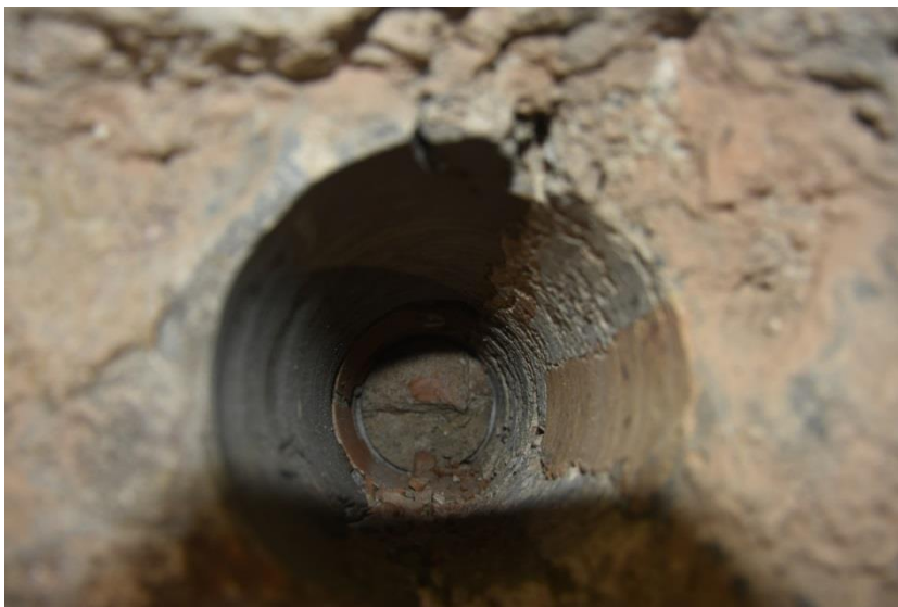
Slika 4.10: Pogled na zgornji del stene vrtine Z2.
