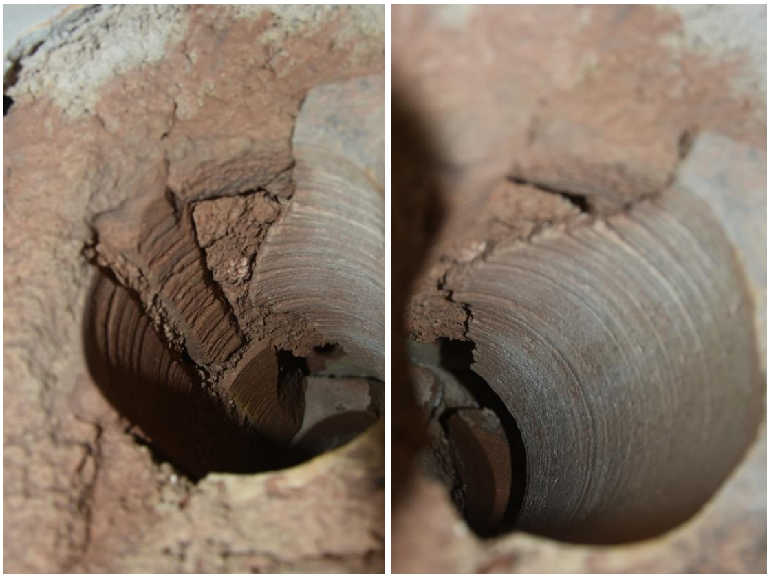
Sliki 4.7 in 4.8: Pregledno mesto Z1 - pogleda na levo in desno stran stene vrtine.
