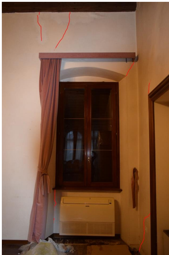
Sliki 3.22 in 3.23: Razpoke na krajnih robovih nadokenskih slopov v južnem zidu.
