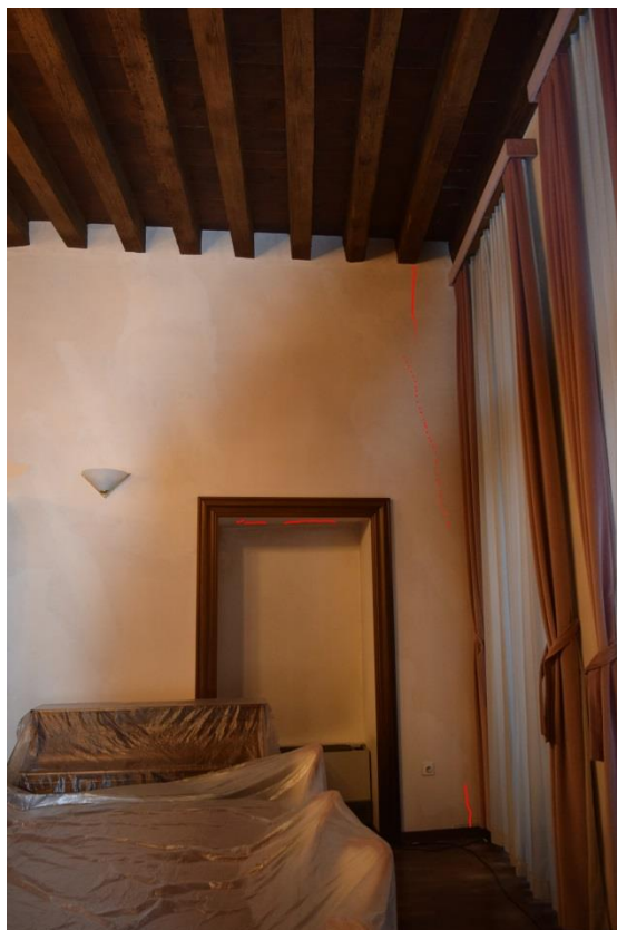
Sliki 3.24 in 3.25: Razpoke v območju niš na južnem in severnem delu zahodnega zunanjega zidu, v niši na severnem delu je vidna tudi vzdolžna razpoka v niši, na zgornji zidni površini. Vidni so tudi sledovi novejšega beleža, s katerim so bile starejše razpoke zatesnjene in so vidni le njihovi sledovi.
