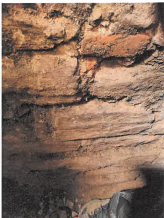
Slika 5: Kamniti bloki z opeko, sondažni izkop S1, 17. 1. 2024 (fotoarhiv 47761d-09)
