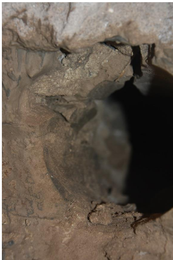
Slike 4.20 do 4.22: Pogled na zgornjo stran vrtine stene Z6 (slika 4.20), kjer je mogoče videti začetek votlavega območja v notranjosti vrtine, ter pogleda na levo in desno stran vrtine Z6 (sliki 4.21 in 4.22).
