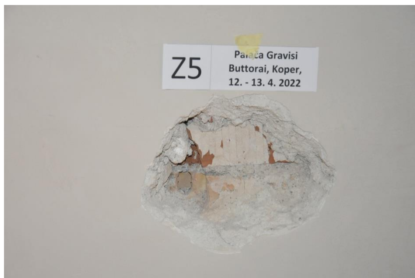
Slika 4.19: Detajlni pogled na pregledno mesto Z5 po odstranitvi ometa in vzorca malte iz spojnice.
