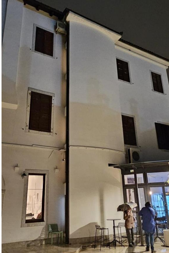
Sliki 3.2 in 3.3: Ožji del južnega pročelja z novim stopnišnim zidom - na obeh robovih zidu so bile v pasu izmika vgrajene a.b. vezi oz. a.b. nosilci, pod oziroma nad njimi pa ozka okna.
