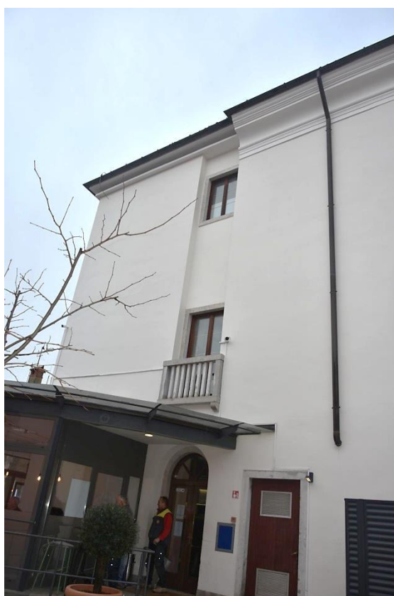
Slika 2.7: Vzhodno pročelje, kjer si sledita dozidek na južni in osnova palače na severni strani. V pritličju je stranski vhod (v hodnik dozidka) in vhod v kurilnico, ki se nahaja v osnovi palače.
