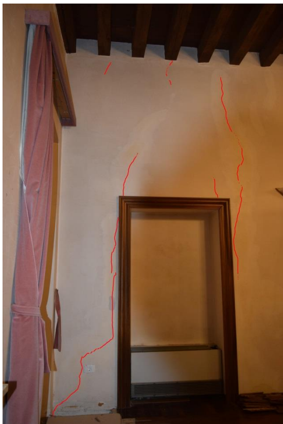
Sliki 3.24 in 3.25: Razpoke v območju niš na južnem in severnem delu zahodnega zunanjega zidu, v niši na severnem delu je vidna tudi vzdolžna razpoka v niši, na zgornji zidni površini. Vidni so tudi sledovi novejšega beleža, s katerim so bile starejše razpoke zatesnjene in so vidni le njihovi sledovi.
