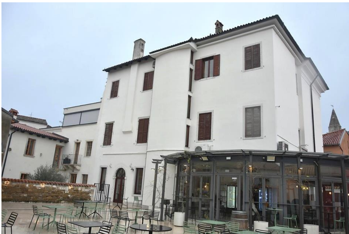
Slika 2.6: Pogled na južno in vzhodno pročelje. Na južnem pročelju si sledijo trije deli različne starosti: osnova palača iz l. 1664, notranje stopnišče iz l. 1992 (v območju izzidka) in JV dozidek iz l. 1969.
