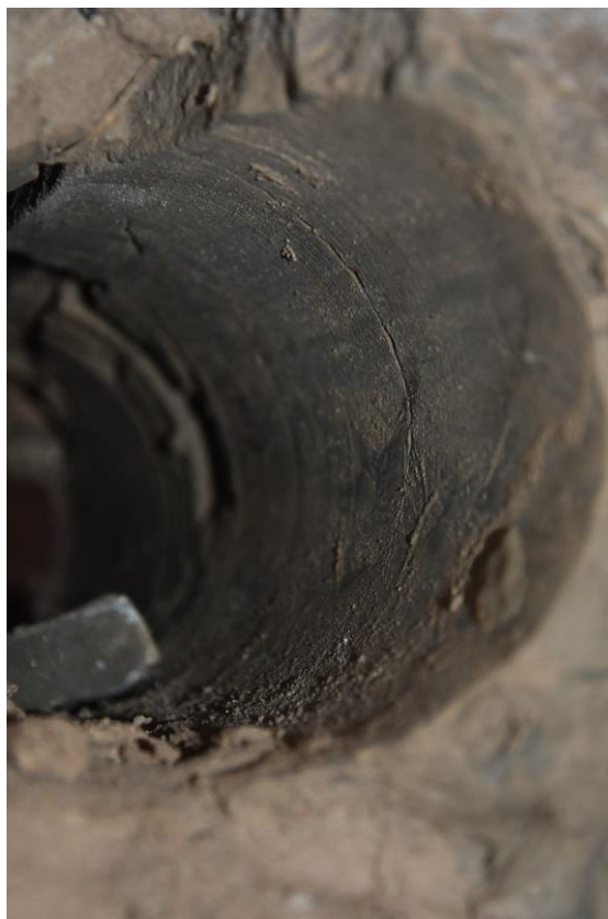
Slike 4.20 do 4.22: Pogled na zgornjo stran vrtine stene Z6 (slika 4.20), kjer je mogoče videti začetek votlavega območja v notranjosti vrtine, ter pogleda na levo in desno stran vrtine Z6 (sliki 4.21 in 4.22).
