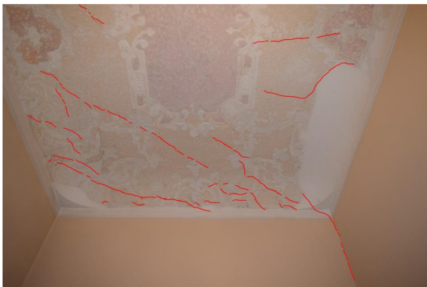
Slika 3.34: Razpoke v stropnem ometu.
