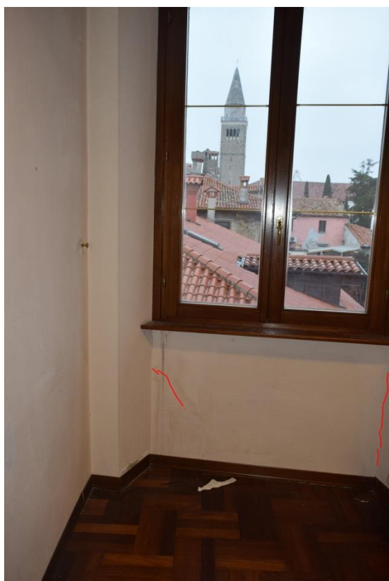
Sliki 3.9 in 3.10: Navpične in poševne razpoke v parapetnih zidovih pod zahodnim in srednjim oknom.
