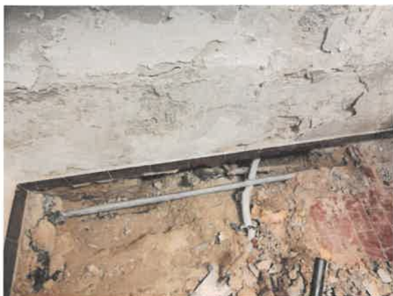
Slika 7: Sondažni izkop S-2, 17. 1. 2024 (fotoarhiv 44685d-48)
