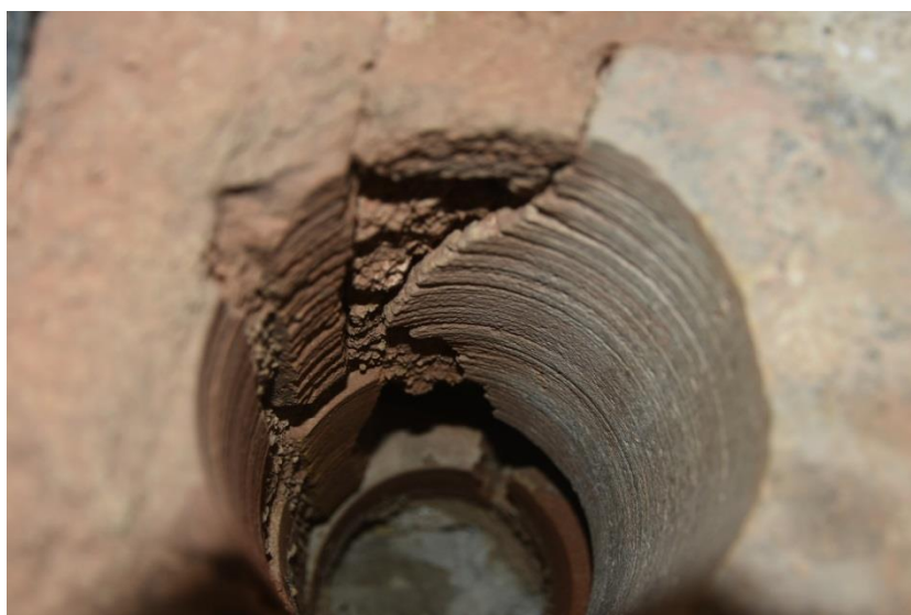
Slika 4.6: Pogled na zgornji del stene vrtine - vidna votlavost na zgornji strani.
