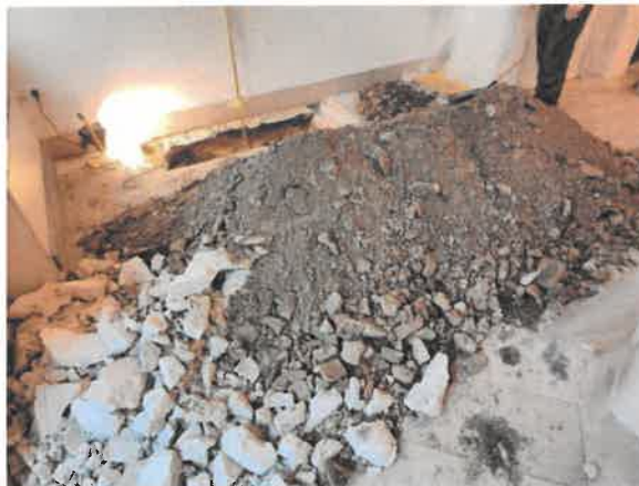
Slika 3: Material iz sondažnega izkopa S-1, 17. 1. 2024 (fotoarhiv 47761d-19)
