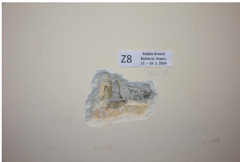
Slika 4.28: Pogled na pregledno mesto Z8.
