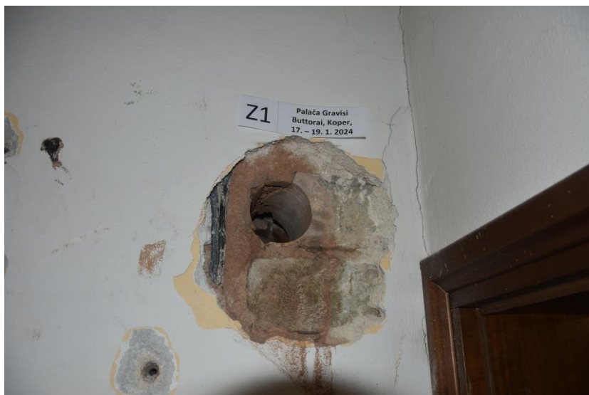
Slika 4.4: Pogled na pregledno mesto Z1.
