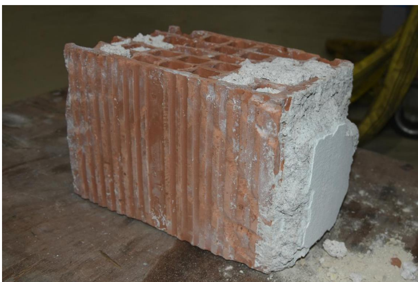
Sliki 4.35 in 4.36: Drugi vzorec votlega opečnega zidak, odvzet iz zidu iz l. 1992 na mestu Z10. S slike 4.35 je razvidno, da je bil ta zidak na krajši stranici (na sliki levo), oslabljen že ob vgradnji, saj je na oslABLJENO zunanjo steno zidak oprijet zunanji omet. Na sliki 4.36 je pogled na neoslABLJENO krajšo stranico, na katero je oprijet večji del notranjega ometa.
