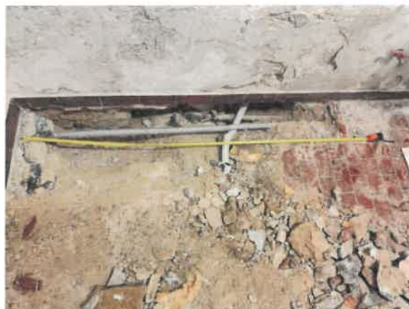
Slika 8: Sondažni izkop S-2, 17. 1. 2024 (fotoarhiv 44685d-52)
