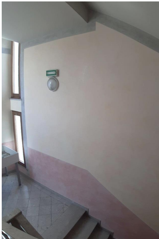
Slika 3.1: Stopnišče, notranji podest med pritličjem in nadstropjem - podest je bil podaljšan do novega zidu na izmaknjenem zunanjem robu stopnišča, na obeh robovih izmika so bile vgrajene a.b. vezi oz. a.b. nosilci, pod oziroma nad njimi pa ozka okna.
