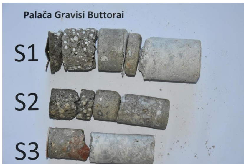
Slika 4.46: Iz sondažnih vrtin v masivnih medetažnih konstrukcijah odvzeta jedra.
