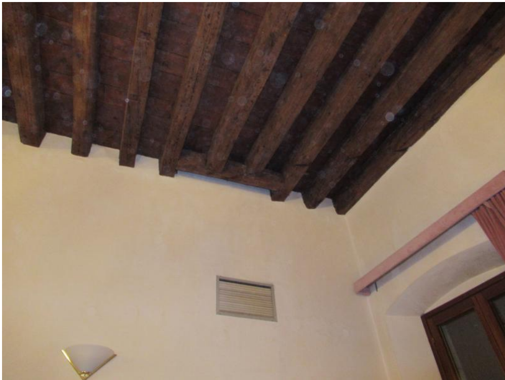
Slika 3.9: Izvedba menjalnika v stropni konstrukciji nad pritličjem.
